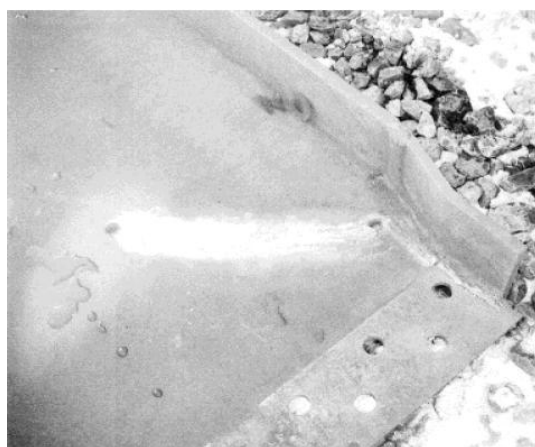
شکل (۵). ترمیم ترک پس از سوراخکاری (a) جوشکاری طول ترک (b) ترمیم با پر کردن مواد مخصوص
