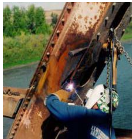
شکل (۵). ترمیم ترک پس از سوراخکاری (a) جوشکاری طول ترک (b) ترمیم با پر کردن مواد مخصوص
