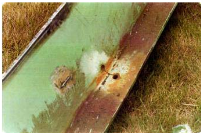
شکل (۴). تعمیر ترک با سوراخ متوقف‌کننده
