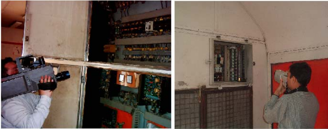
شکل ۲- نمونه‌ای از دوربین‌های آنالیز حرارتی در حال عیب‌یابی تجهیزات واگنهای مولد برق
